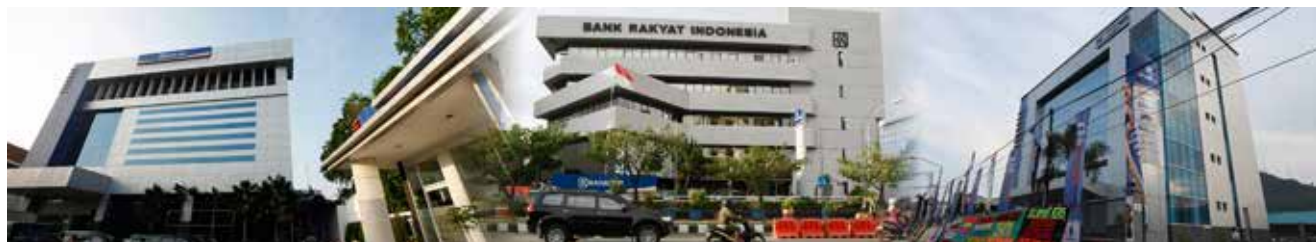
KANTOR WILAYAH REGIONAL OFFICE
